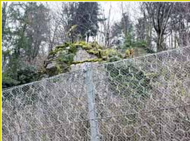
Wo Wald allein zu wenig wirkt, unterstützen technische Verbauungen den Schutz. Foto: Amt für Wald
